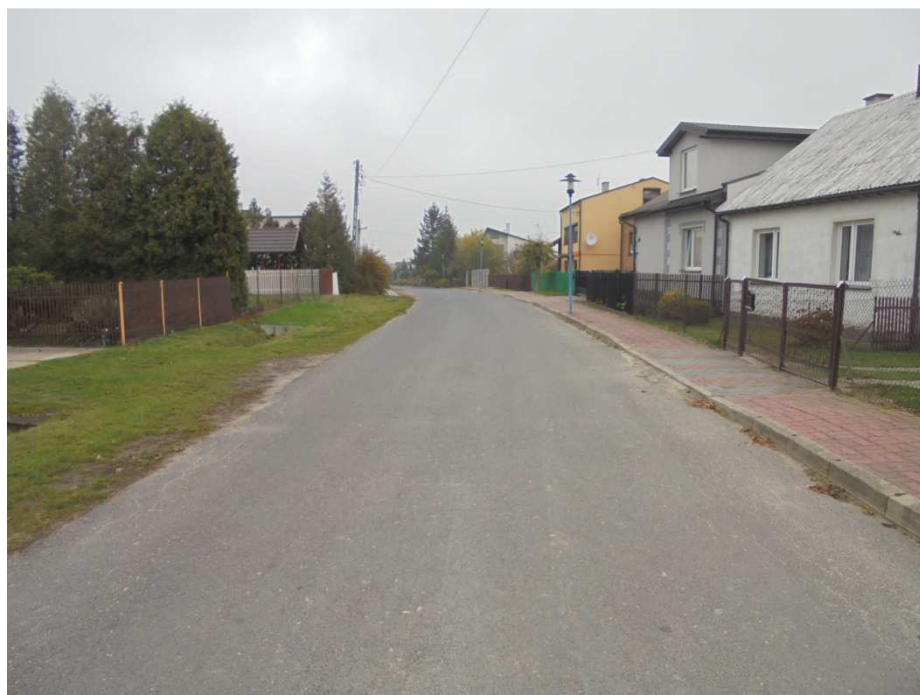
Wykonywanie odwiertów Odwiert nr 3, ul. Nowe Osiedle, km 0+570
