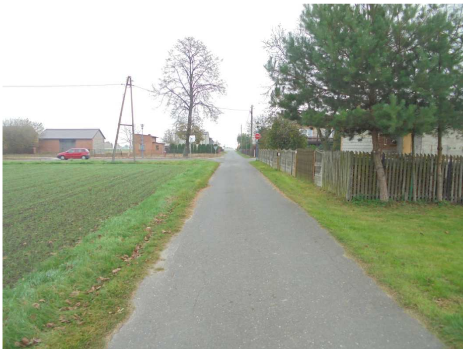
Wykonywanie odwiertów Odwiert nr 4, ul. Bociania
