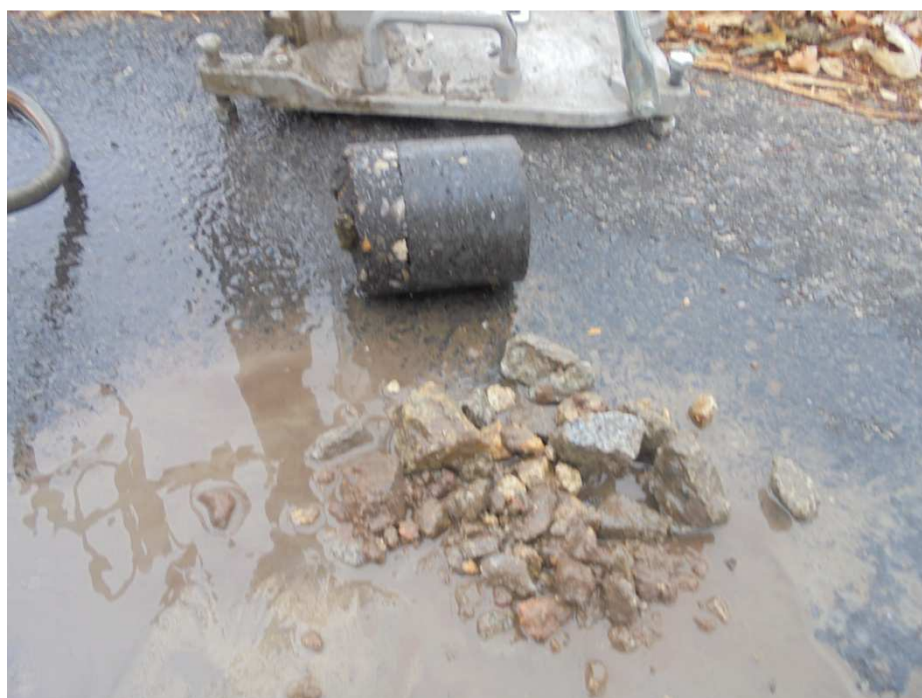
Wykonywanie odwiertów 5+7,5cm bitum, 15cm kruszywo granitowe, nasyp budowlany
