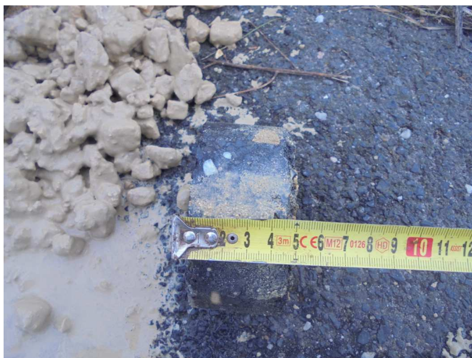
Wykonywanie odwiertów 5cm bitum, 15cm kruszywo/kamień wapienny, nasyp budowlany/piasek
