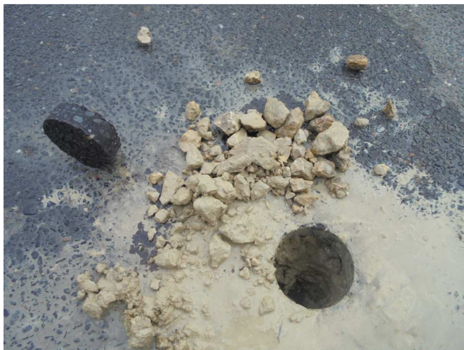
Wykonywanie odwiertów 4cm bitum, 16cm tłuczeń/kamień wapienny, nasyp budowlany/ziemia
