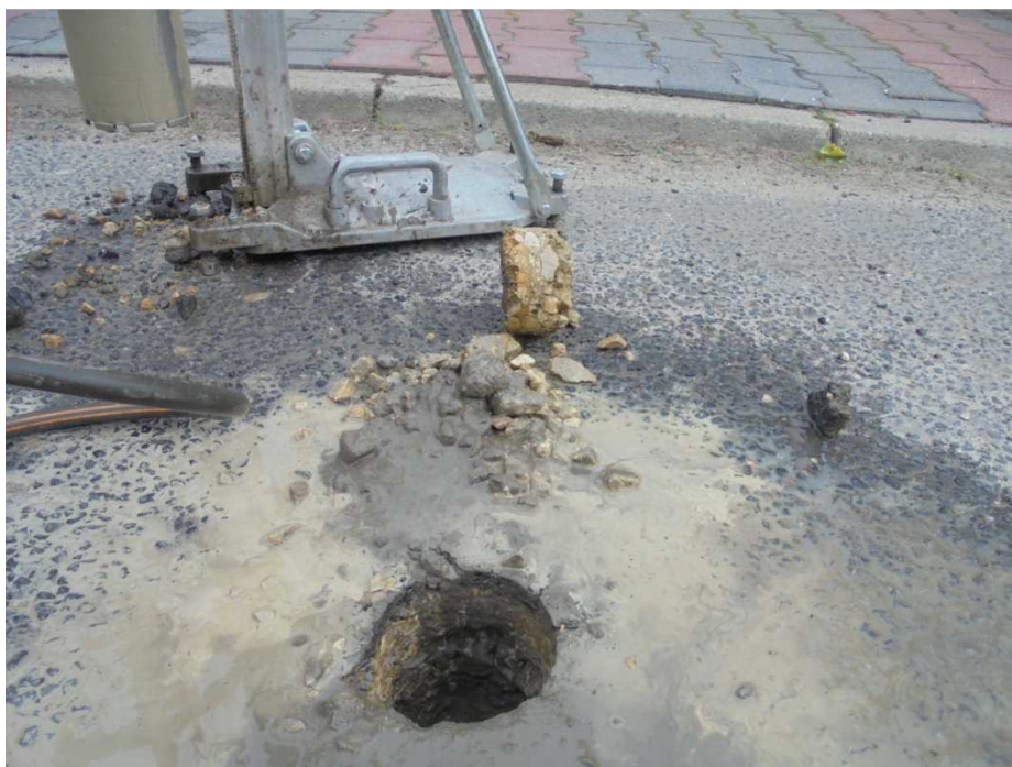
Wykonywanie odwiertów 2cm bitum, 18cm tłuczeń/kruszywo, nasyp budowlany
