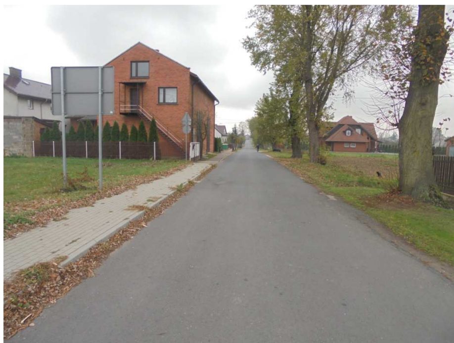
Wykonywanie odwiertów Odwiert nr 1, ul. Nowe Osiedle, km 0+010
