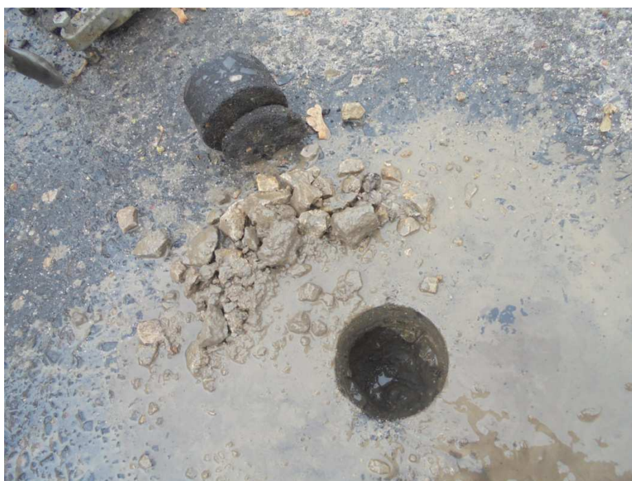
Wykonywanie odwiertów 5,5+2,5cm bitum, 11cm kruszywo, tłużeń, nasyp budowlany
