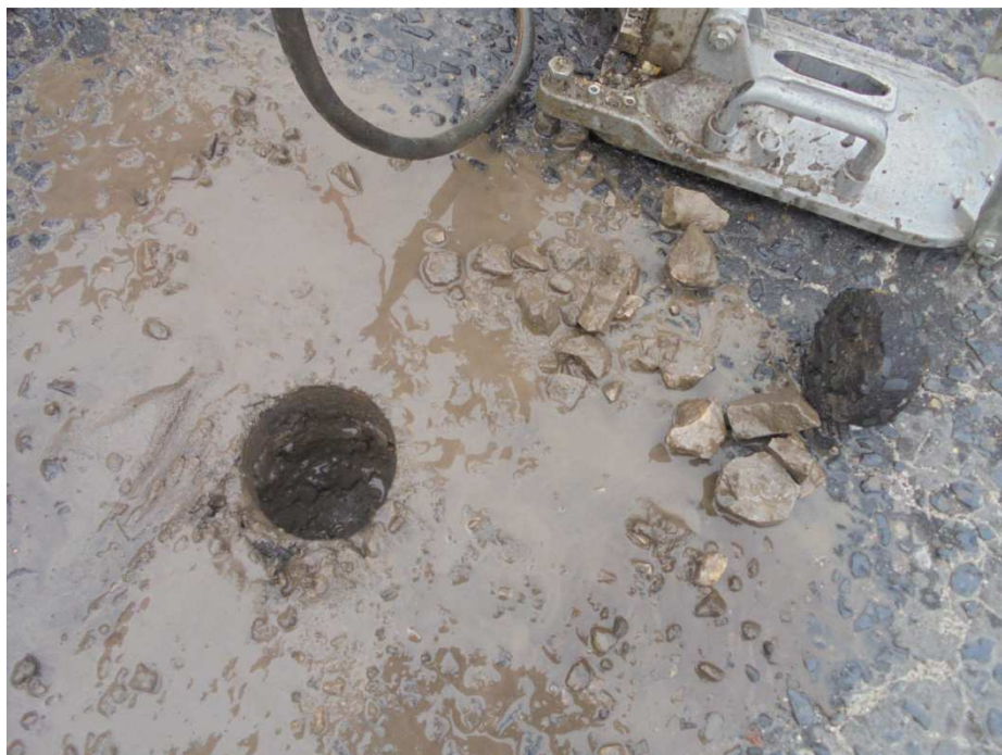
Wykonywanie odwiertów 5cm bitum, 10cm kruszywo, tłuźeń, nasyp budowlany
