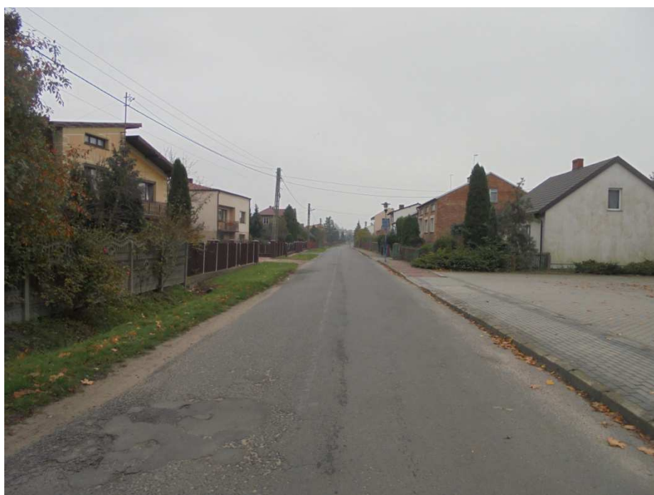
Wykonywanie odwiertów Odwiert nr 4, km 0+750
