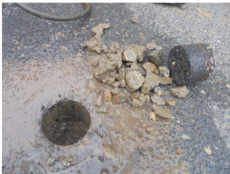
Wykonywanie odwiertów 8cm bitum, 10cm kruszywo granitowe, piasek
