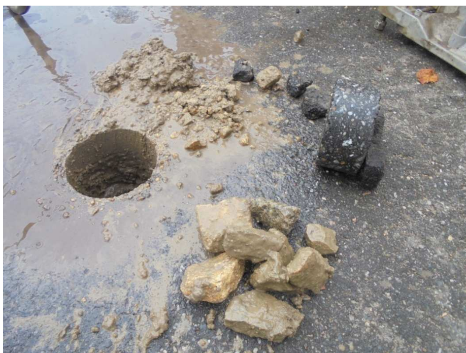
Wykonywanie odwiertów 5+2,5cm bitum, 10cm tłużeń/kruszywo/ kawałki kostki granitowej
