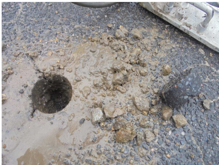
Wykonywanie odwiertów 5cm bitum, 12cm tłućzeń/kruszywo/ kawałki kostki granitowej, nasyp budowlany
