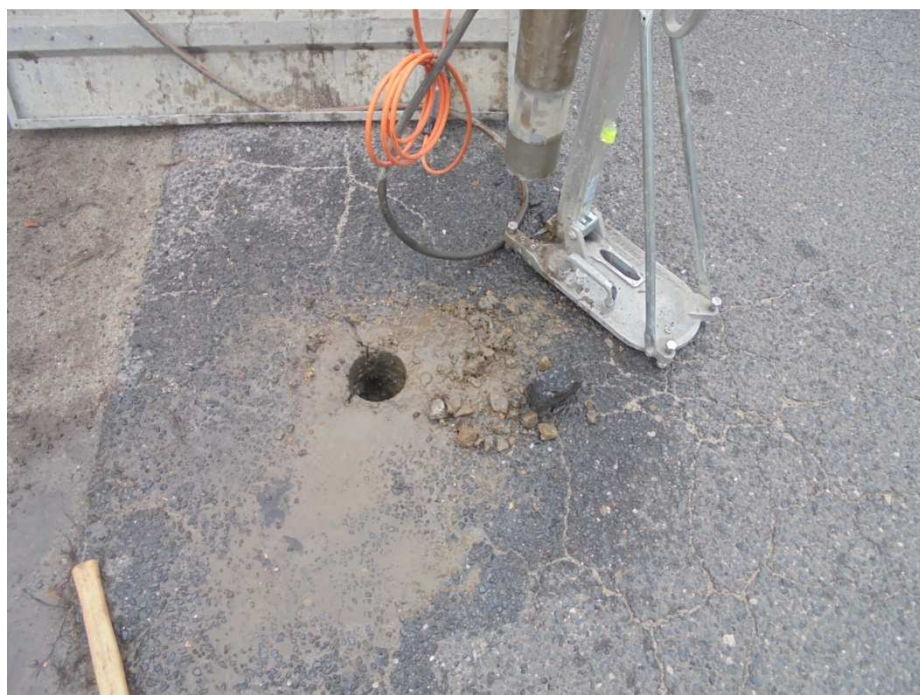
Wykonywanie odwiertów Odwiert nr 2, ul. Szkolna, km 0+140
