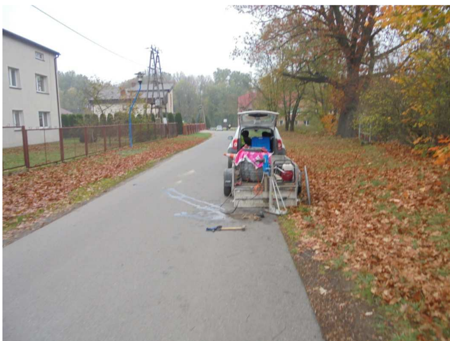
Wykonywanie odwiertów Odwiert nr 1, ul. Północna
