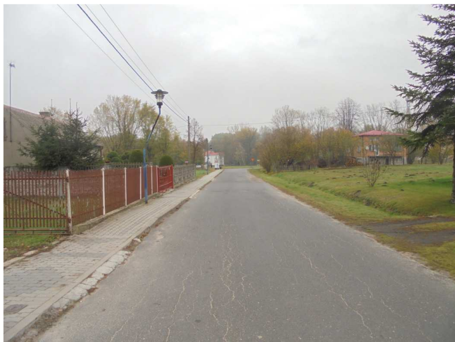
Wykonywanie odwiertów Odwiert nr 3, ul. Szkolna, km 0+330
