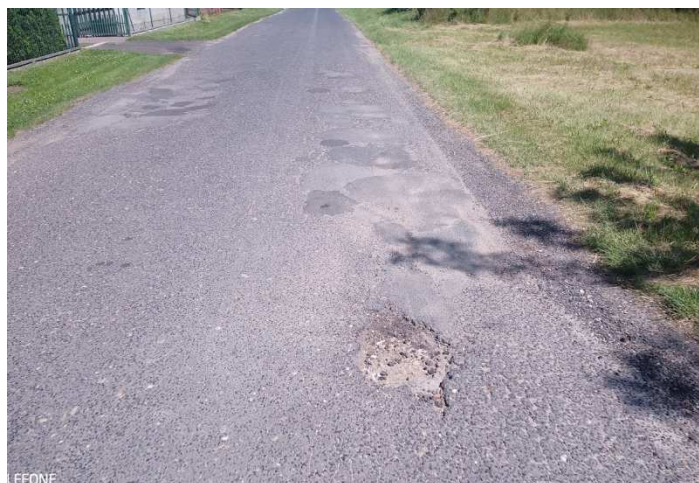
Rozbiórka wykruszającej się lokalnie warstwy nawierzchni bitumicznej, rozbiórka "łat", wyrównanie zaniżonej koleiny
