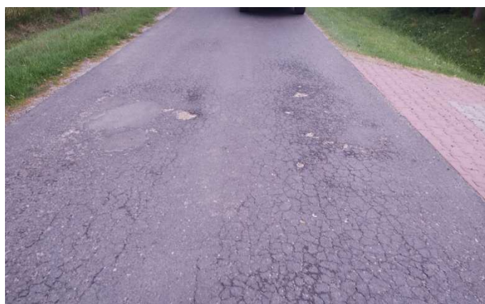
Rozbiórka wykruszającej się lokalnie warstwy nawierzchni bitumicznej, wyrównanie zaniżonej istniejącej krawędzi, wykonanie w-wy wyrównawczej mieszanką mineralno bitumiczną
