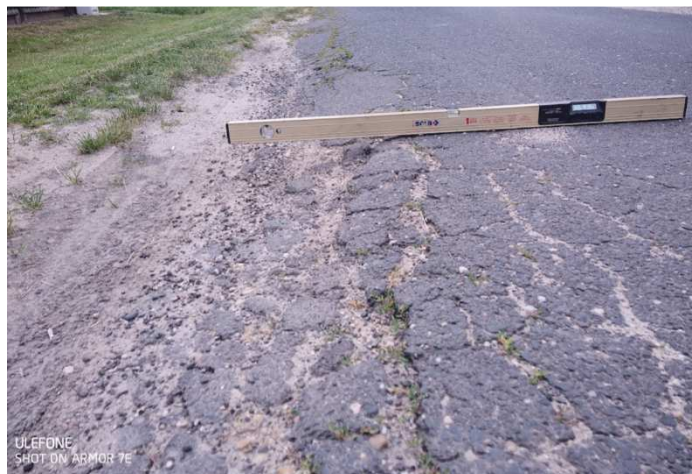
Wyrównanie zaniżonej istniejącej krawędzi drogi gminnej mieszanką mineralno bitumiczną
