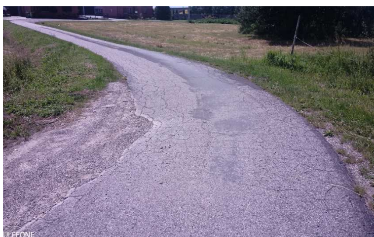
Poszerzenie podbudowy, ułożenie warstwy wiążącej i wyrównanie zaniżonej istniejącej krawędzi drogi gminnej mieszanką mineralno bitumiczną
