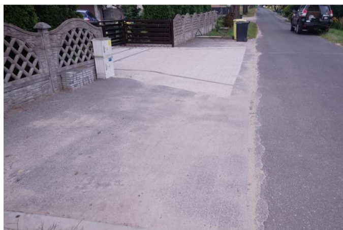
Rozbiórka i podniesienie krawężników oraz przełożenie nawierzchni zjazdów do wysokości nowej nawierzchni bitumicznej
