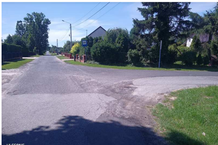
Rozbiórka wykruszającej się lokalnie warstwy nawierzchni bitumicznej skrzyżowania, uzupełnienie ubytków mieszanką mineralno bitumiczną gr. 5cm
