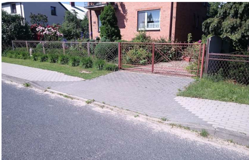
Rozbiórka i podniesienie krawężnika oraz przełożenie nawierzchni zjazdów i chodnika do wysokości nowej nawierzchni bitumicznej
