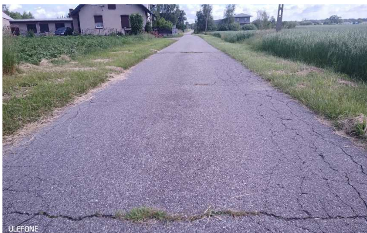
Naprawa pęknięć poprzecznych np. przy użyciu żywic bitumicznych (usunięcie roślinności, oczyszczenie pęknięcia, aplikacja wypełnienia)
