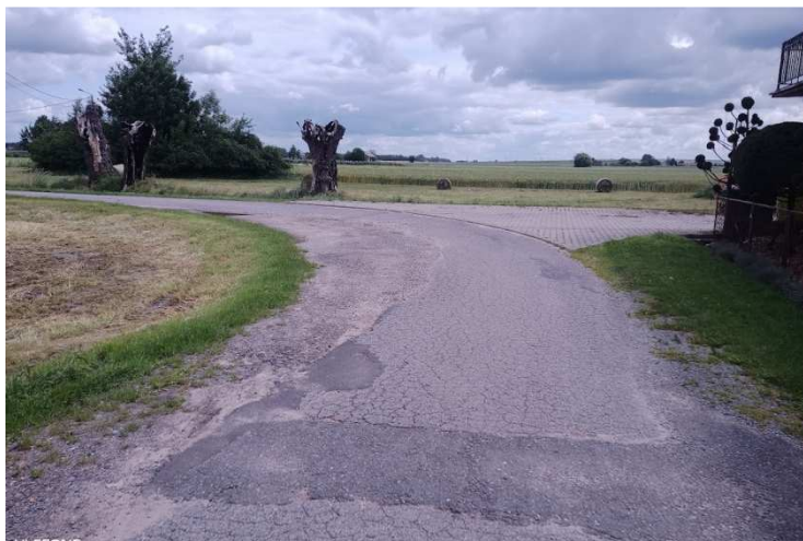
Poszerzenie podbudowy, ułożenie warstwy wiążącej i wyrównanie zaniżonej istniejącej krawędzi drogi gminnej mieszanką mineralno bitumiczną
