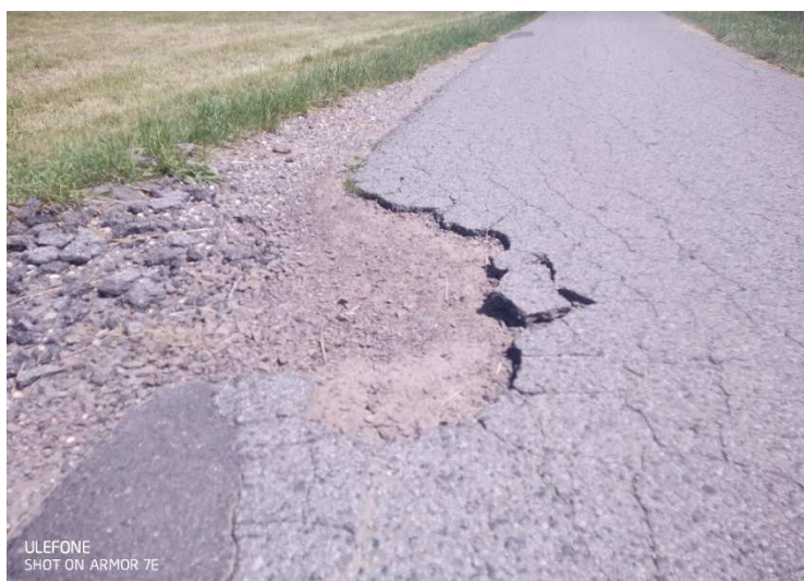
Rozbiórka wykruszającej się lokalnie warstwy nawierzchni bitumicznej, wyrównanie zaniżonej istniejącej krawędzi
