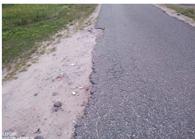
Rozbiórka wykruszającej się nawierzchni bitumicznej, uzupełnienie i wyrównanie zaniżonej istniejącej krawędzi mieszanką mineralno bitumiczną
