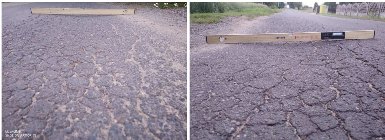
Wyrównanie zaniżonej istniejącej krawędzi drogi gminnej oraz koleiny mieszanką mineralno bitumiczną
