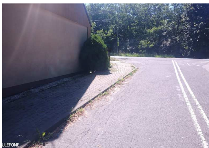
Rozbiórka i przełożenie istniejącego krawężnika w dostosowaniu do nowej wysokości nawierzchni drogi min. 6cm światła
