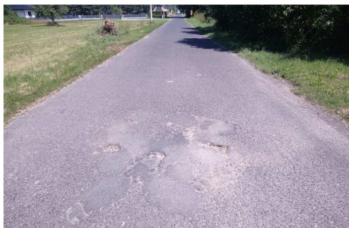
Rozbiórka wykruszającej się lokalnie warstwy nawierzchni bitumicznej, wyrównanie zaniżonej istniejącej krawędzi
