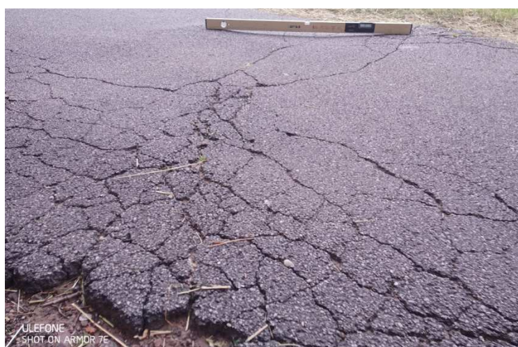
Rozbiórka istniejących przełomów drogowych, korytowanie, wykonanie w-wy mrozochronnej, wykonanie podbudowy z kruszywa łamanego oraz odtworzenie dwóch warstw nawierzchni bitumicznej
