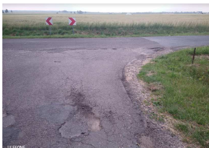
Rozbiórka wykruszającej się nawierzchni bitumicznej na skrzyżowaniu z drogą gminną, wyrównanie zaniżonej istniejącej krawędzi, wykonanie w-wy wyrównawczej mieszanką mineralno bitumiczną
