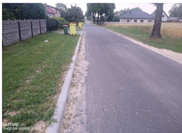
Poszerzenie nawierzchni drogi przy istniejącym krawężniku
