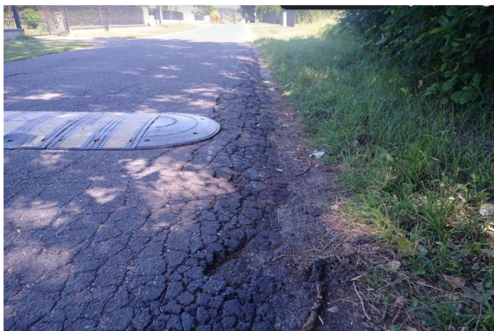
Rozbiórka i przełożenie istniejącego progu podrzutowego. Rozbiórka rozkruszonej nawierzchni i wyrównanie zaniżonej istniejącej krawędzi drogi gminnej mieszanką mineralno bitumiczną
