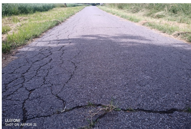
Naprawa pęknięć poprzecznych np. przy użyciu żywic bitumicznych (usunięcie roślinności, oczyszczenie pęknięcia, aplikacja wypełnienia)
