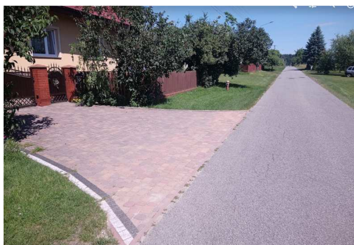
Rozbiórka i podniesienie obrzeża oraz przełożenie nawierzchni zjazdów do wysokości nowej nawierzchni bitumicznej
