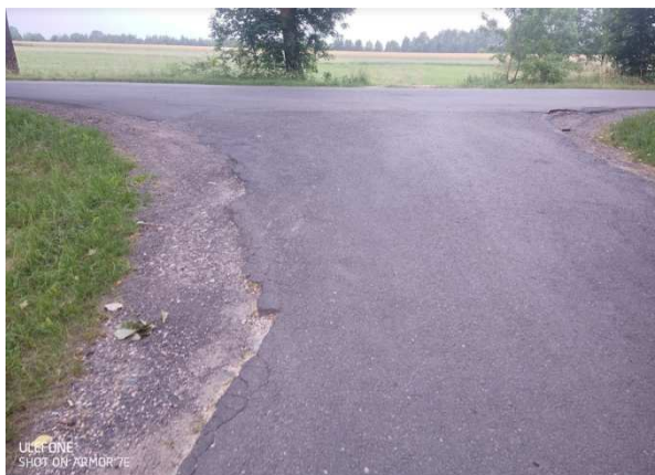
Poszerzenie istniejącego wyluczenia na skrzyżowaniu z drogą powiatową, wyrównanie zaniżonej istniejącej krawędzi
