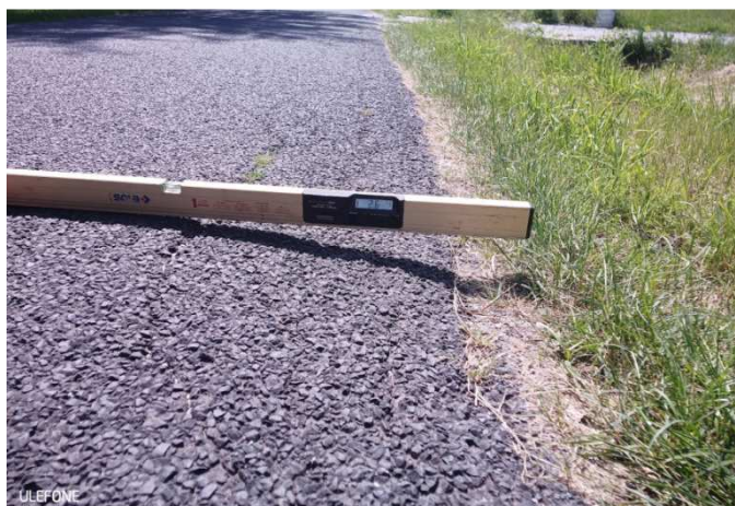
Wyrównanie zaniżonej istniejącej krawędzi drogi gminnej mieszkanką mineralno bitumiczną
