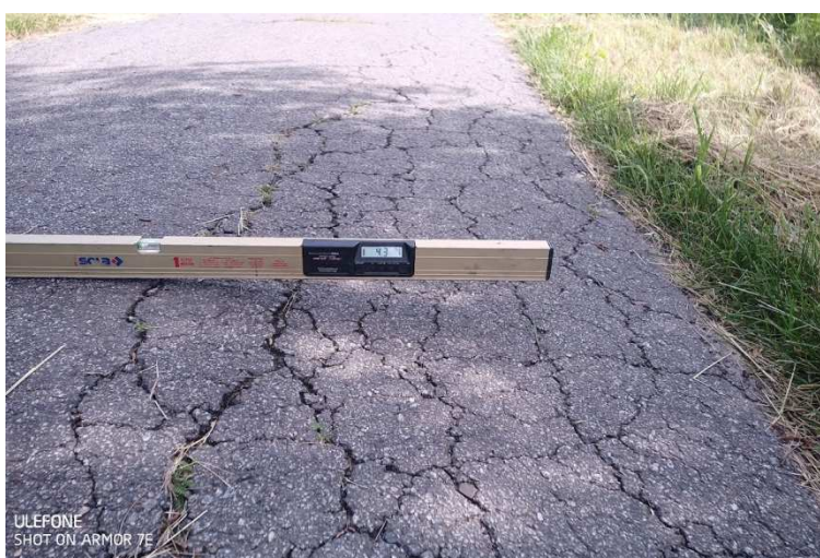
Wyrównanie zaniżonej istniejącej krawędzi drogi gminnej mieszkanką mineralno bitumiczną
