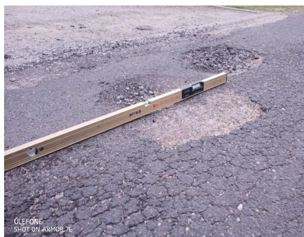
Rozbiórka wykruszającej się lokalnie warstwy nawierzchni bitumicznej, przełożenie krawężników wyrównanie zaniżonej istniejącej krawędzi, wykonanie w-wy wyrównawczej mieszanką mineralno bitumiczną
