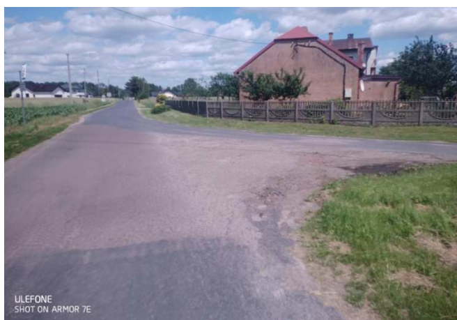
Rozbiórka wykruszającej się lokalnie warstwy nawierzchni bitumicznej skrzyżowania, uzupełnienie ubytków mieszkanką mineralno bitumiczną gr. 5cm
