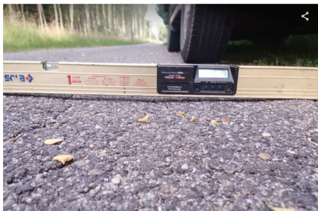
Wyrównanie koleiny mieszanką mineralno bitumiczną
