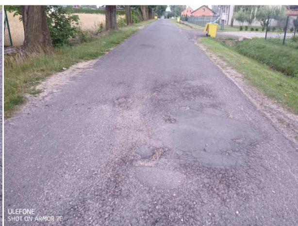
Rozbiórka wykruszającej się lokalnie warstwy nawierzchni bitumicznej, przełożenie krawężników wyrównanie zaniżonej istniejącej krawędzi, wykonanie w-wy wyrównawczej mieszanką mineralno bitumiczną
