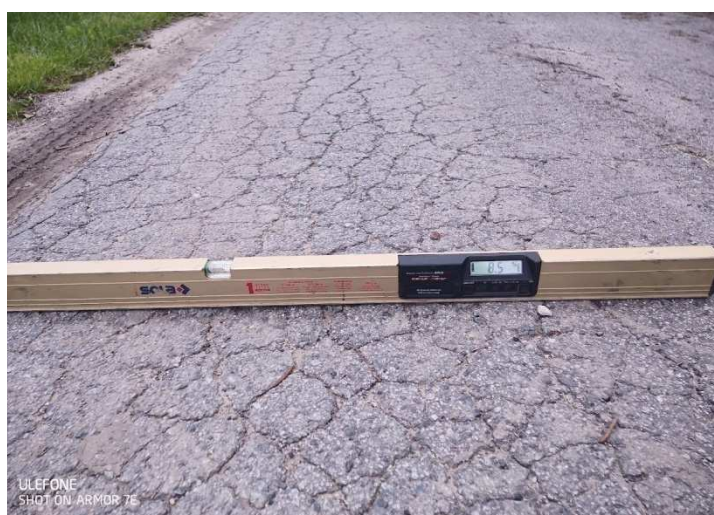
Wyrównanie zaniżonej istniejącej krawędzi drogi gminnej oraz wyrównanie kolein mieszanką mineralno bitumiczną
