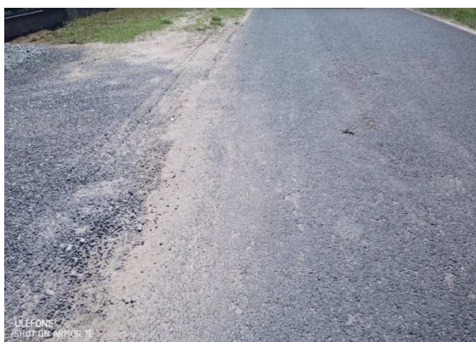
Rozbiórka wykruszającej się lokalnie warstwy nawierzchni bitumicznej, wyrównanie zaniżonej istniejącej krawędzi, wypełnienie ubytków mieszkanką mineralno bitumiczną
