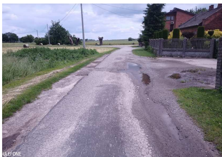
Rozbiórka wykruszającej się lokalnie warstwy nawierzchni bitumicznej, wyrównanie zaniżonej istniejącej krawędzi, wypełnienie ubytków mieszanką mineralno bitumiczną
