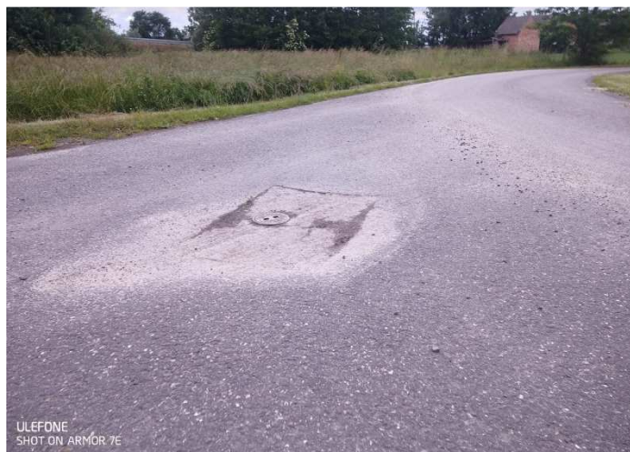
Regulacja istniejących zasuw wodociągowych, uzupełnienie ubytków mieszkanką mineralno bitumiczną
