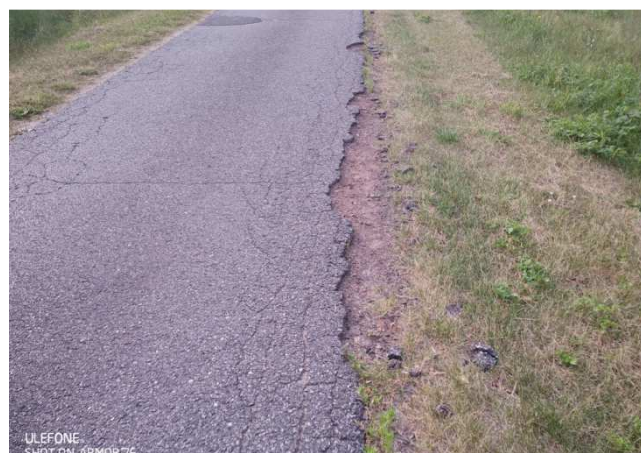
Rozbiórka wykruszającej się nawierzchni bitumicznej, uzupełnienie i wyrównanie zaniżonej istniejącej krawędzi mieszanką mineralno bitumiczną
